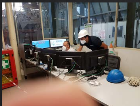
La cabina di controllo dei processi produttivi
